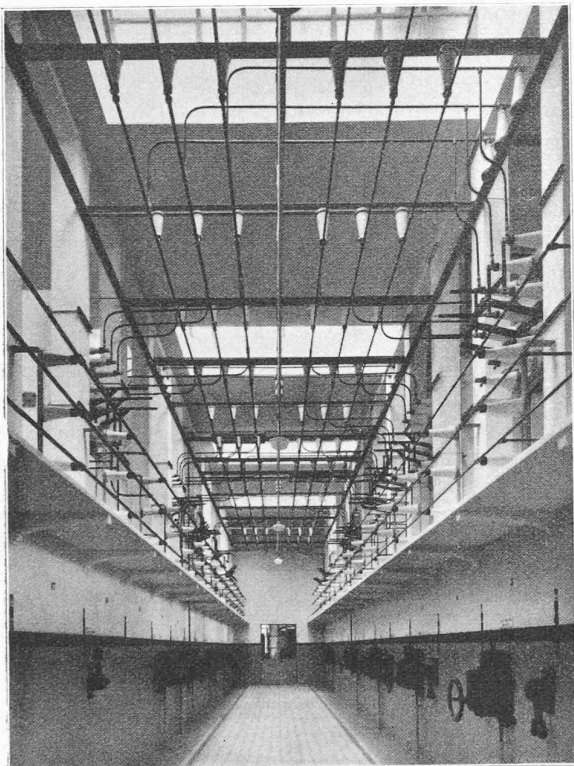
Fig. 12. — Poste de Montcherand. Vue du couloir central.
