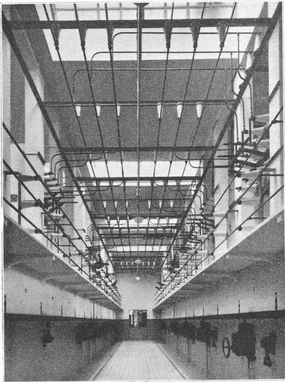
Fig. 12. — Poste de Montcherand. Vue du couloir central.
