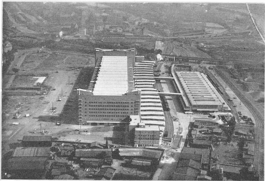
Fig. 1. — Vue à vol d'oiseau de l'ensemble des installations.
