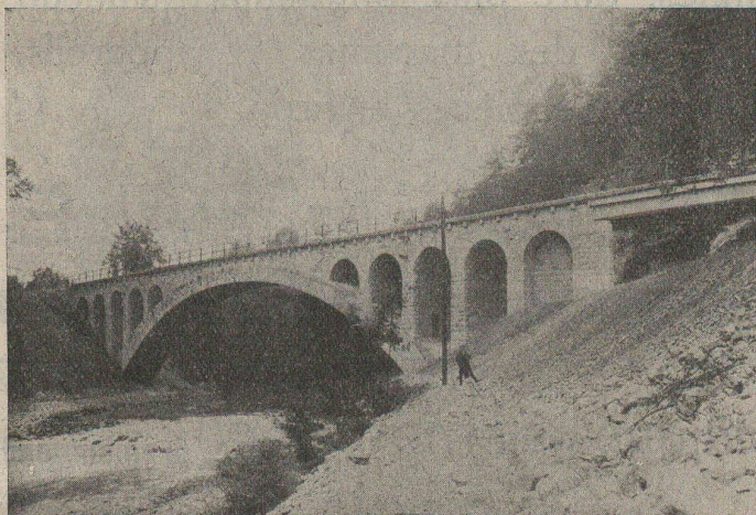
Pont amont C. F. F. du „Kessiloch“.
