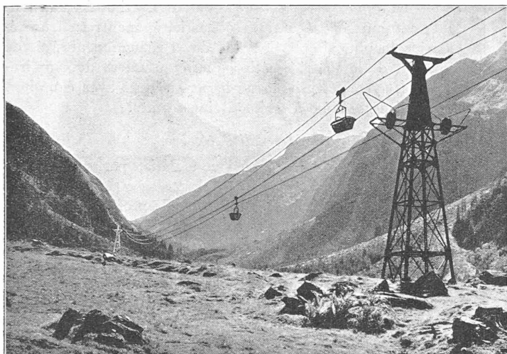
Fig. 2. — Grande portée entre pylônes en fer.
