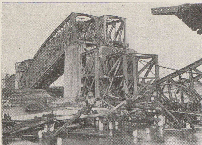
Fig. 8. — Pont sur la Dembica, près de Wislok, miné par les Autrichiens (1915).
