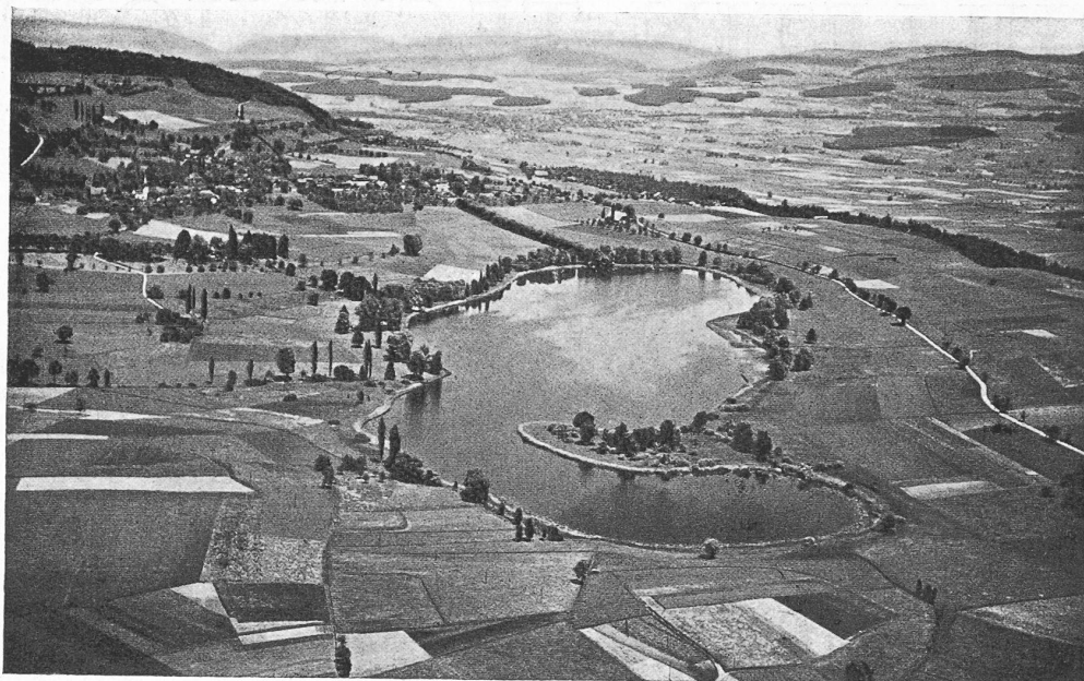
Fig. 1. — Aérophoto. — Vue d'ensemble pour un projet d'accumulation.
