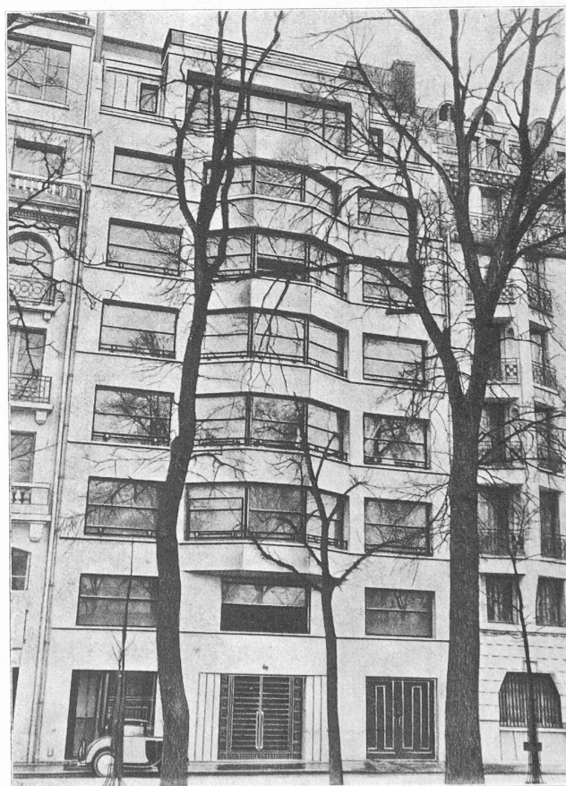
Fig. 2. — Façade d'immeuble. (Architecte : M. Roux-Spitz).
