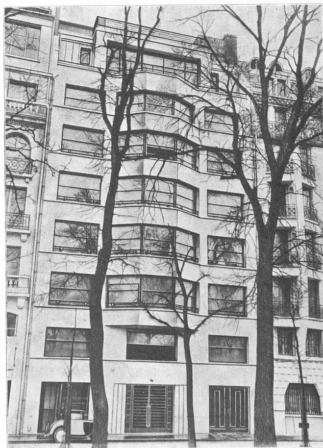
Fig. 2. — Façade d'immeuble. (Architecte : M. Roux-Spitz).
