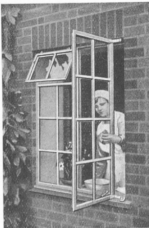
Fig. 9. — Fenêtre s'ouvrant à l'extérieur et pivotant autour d'un axe non situé dans son plan.
