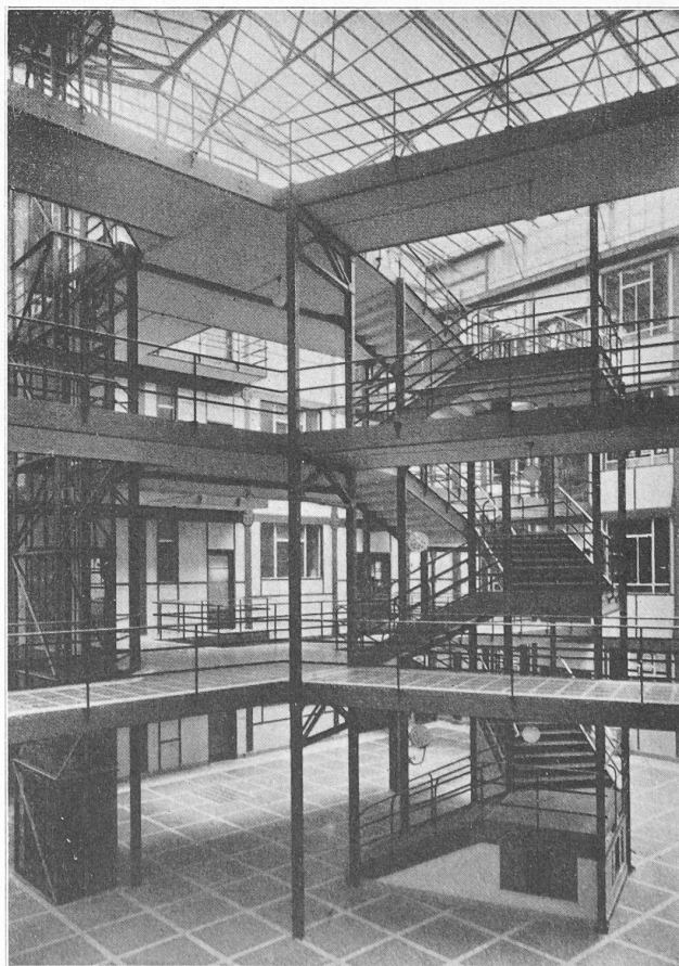
Fig. 4. — Cour vitrée, avec l'escalier central et les passerelles.
