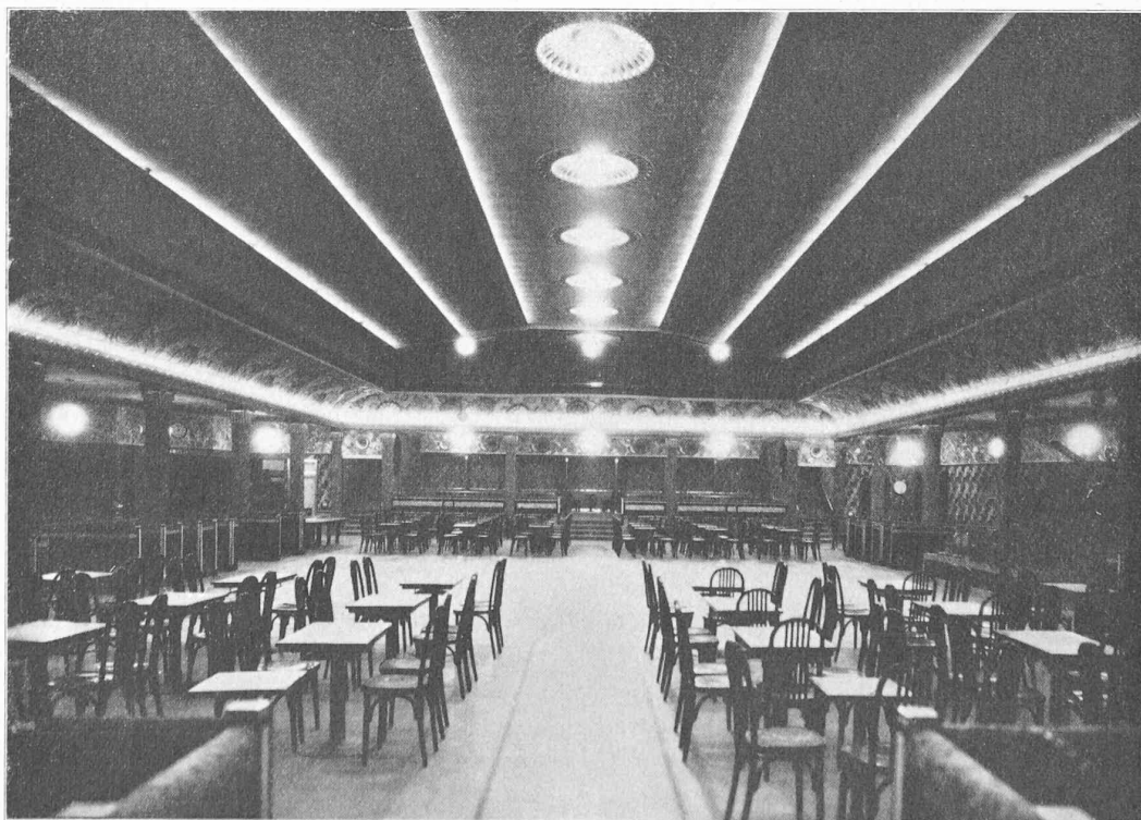
Fig. 3. — Salle, avec diffuseurs et grillages pour l'entrée et la sortie de l'air, adaptés à l'architecture. Photos A. Détraz, Genève.
