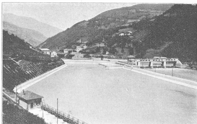
Fig. 4. — Vue du bassin d'accumulation, presque entièrement rempli, avec le dessableur émergeant à peine. A gauche, la route du Brenner et les vannes d'entrée du tunnel. A droite l'Isarco, le barrage et la voie ferrée Brenner-Bolzano.
