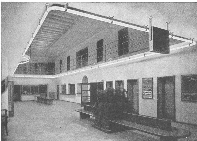
Fig. 14. — Eclairage du hall des guichets de l'aérogare de Dubendorf par tubes à filament de tungstène. (Architectes: MM. Kündig et Oetiker, à Zurich.)
