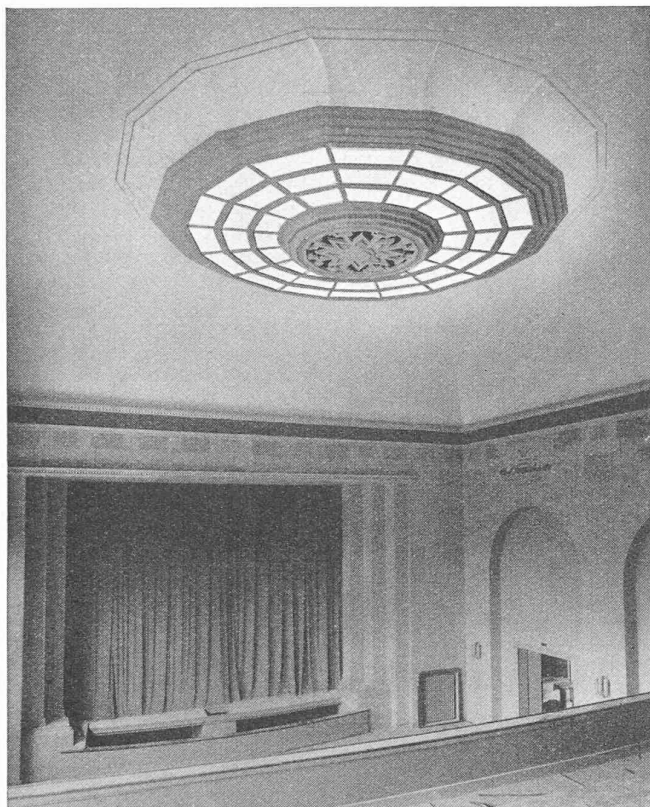
Fig. 20. — Casino d'Yverdon. Luminaire pour éclairage multicolore, direct et indirect. (Architecte : M. L. Ruhe, à Yverdon.)
