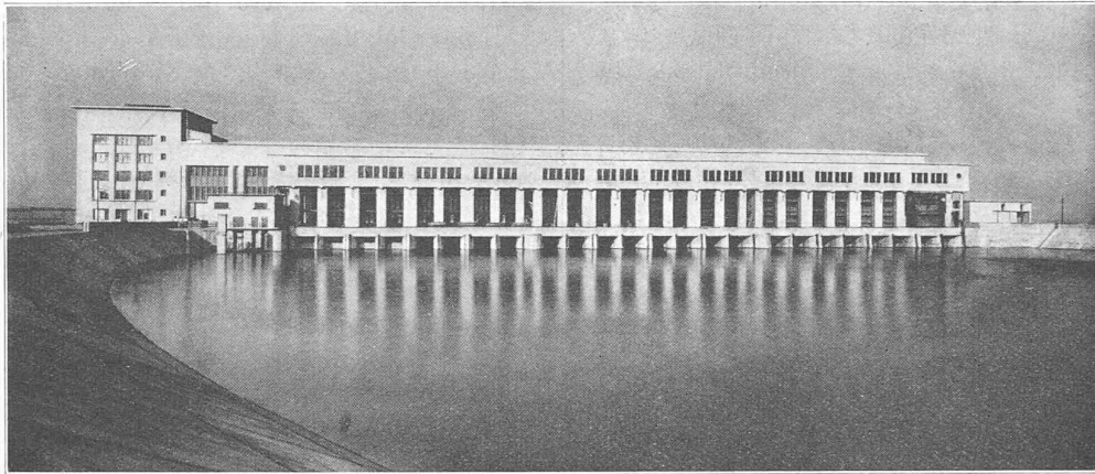
Fig. 5. — Vue générale de l'usine, prise d'amont.
