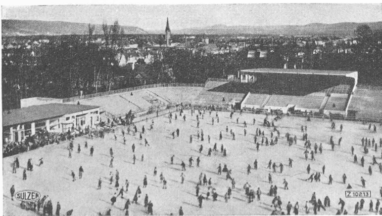
Fig. 1. — Patinoire artificielle, en plein air, de la ville de Bâle, équipée d'une installation frigorifique Sulzer comportant deux compresseurs d'ammoniac de 500 000 frig/h chacun.
