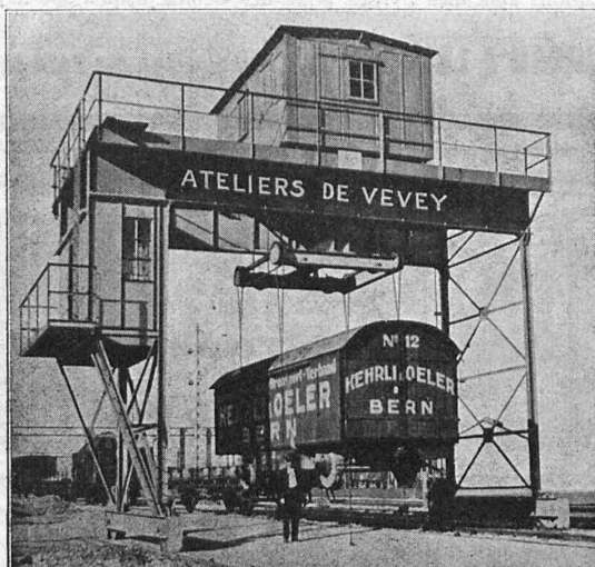
GRUE A PORTIQUE ROULANT, 40 T., DE LA GARE DE WEYERMANSHAUS, A BERNE
