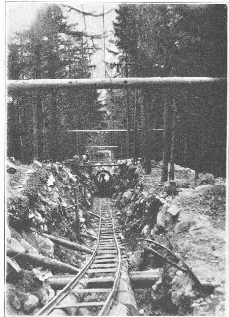
Fig. 16. — Transport d'un tuyau dans la tranchée du siphon de Saleinaz.
