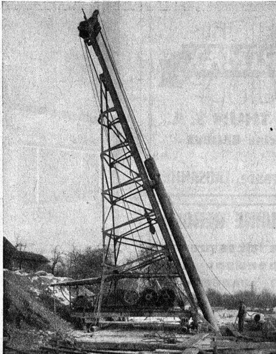
Sonnente Franki en position pour pieux inclinés.
