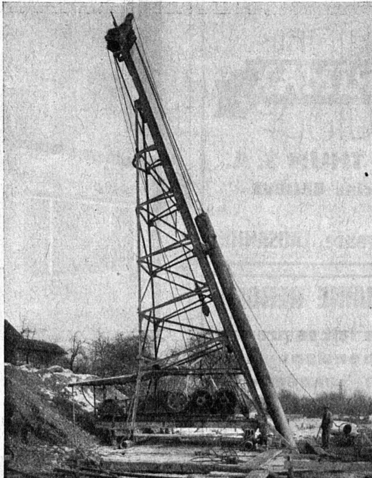
Sonnette Franki en position pour pieux inclinés.
