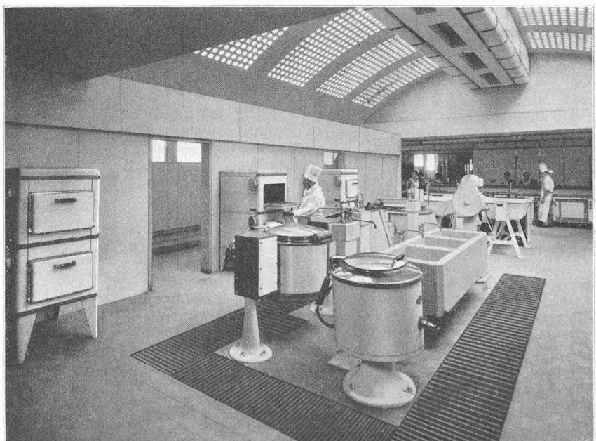
Fig. 3. — Cuisine de l'immeuble Vienne-Rocher. En plus des appareils visibles, elle comprend aussi des plonges, des chauffe-eau et un four à pâtisserie. Photo Kollar.
