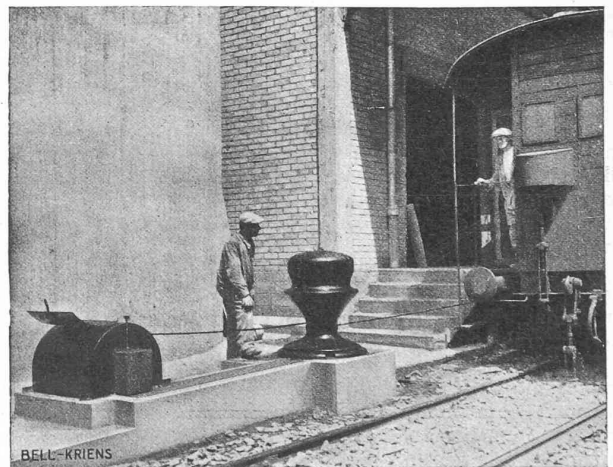
Fig. 2. — Cabestan avec enrouleur horizontal, demi-noyé.
