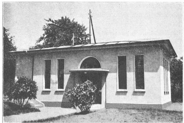
Fig. 1. — Station de pompage de la ville de Rolle.
