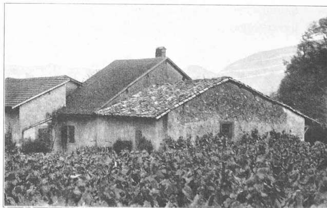
Fig. 1. — Type de maison rurale avec toit en tuiles romaines. (Confignon).
