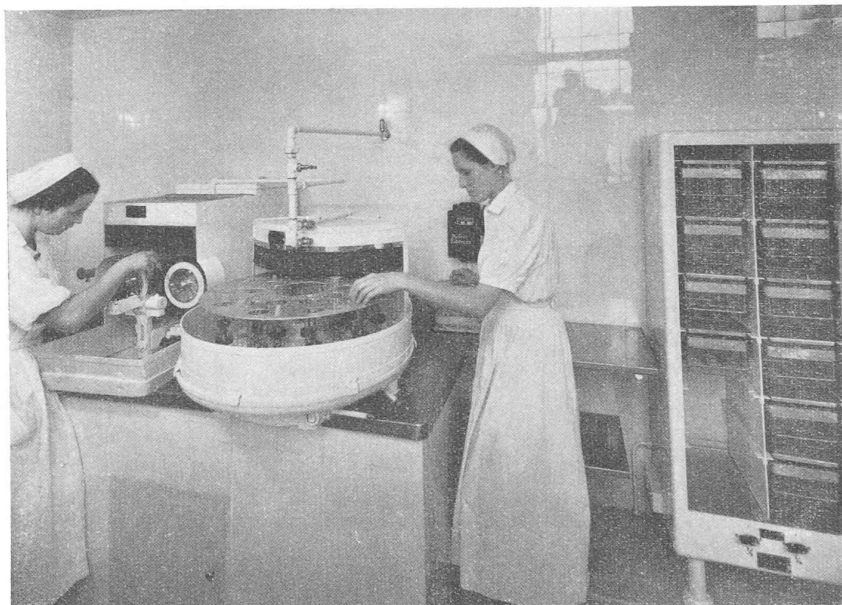
Fig. 5. — Cuisine diététique : machines à laver et à rincer les biberons, et armoire chauffante.
