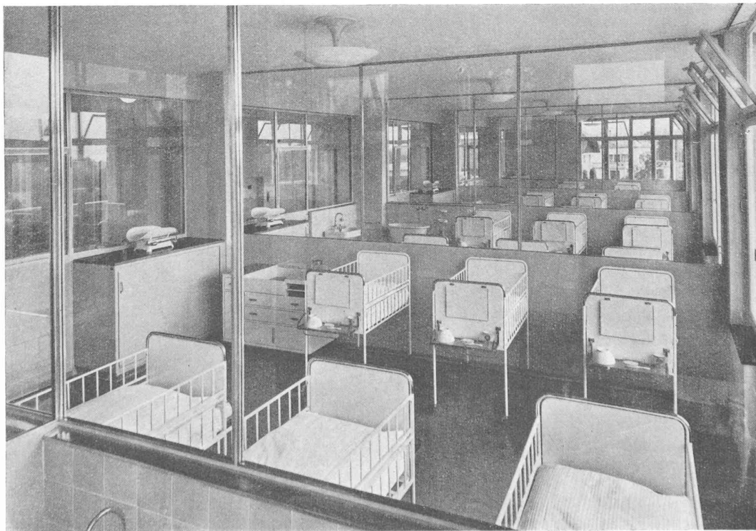
Fig. 7. — Salle des nourrissons.
