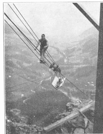
Fig. 7. — Montage d'un câble porteur.
