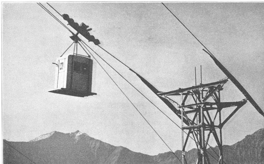
Fig. 4. — Cabine au passage du pylône.
