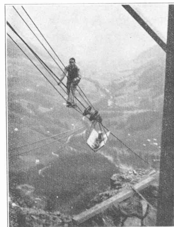
Fig. 7. — Montage d'un câble porteur.
