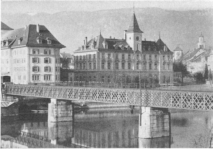
L'ancien pont, à voie unique.
