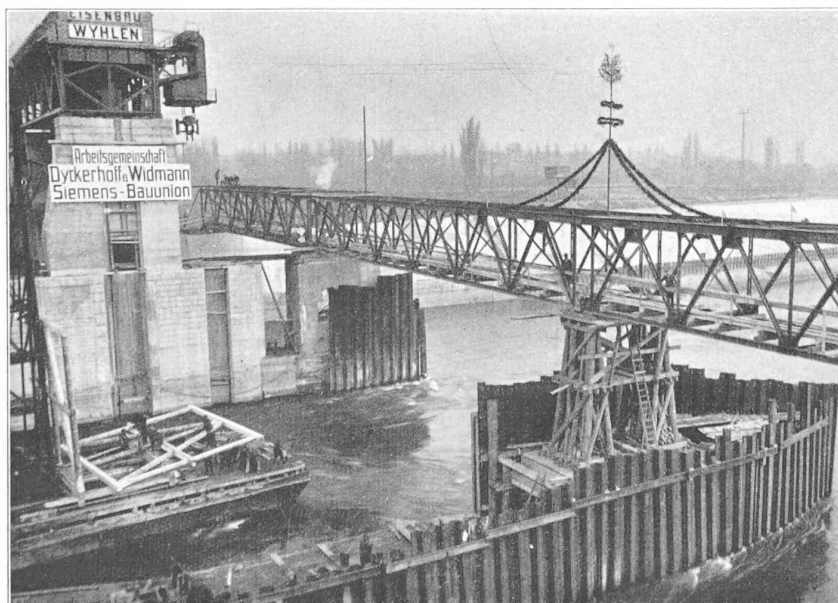
[ Fig. 15. — Pile III : 2 e étape de travaux. — Palée provisoire. — Pont de service amont. — Paroi de palplanches entourant la base de la pile.
