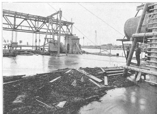
Fig. 20. — Fouille du seuil 4 inondée lors d'une crue du Rhin. Au premier plan : matériaux charriés par le fleuve.
