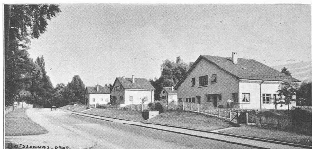
Ensemble de la route de Malagnou.
