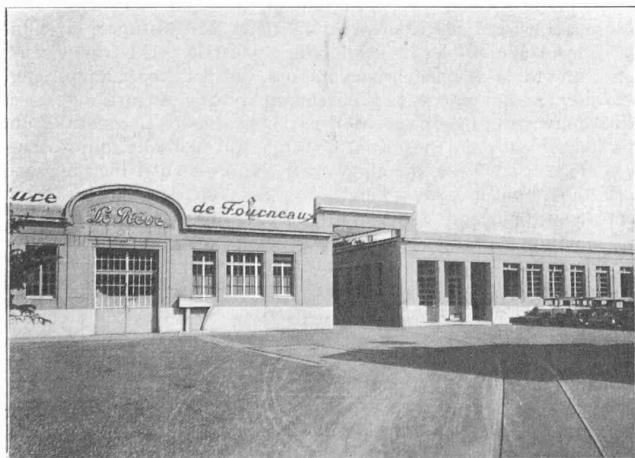
Cour d'entrée et partie de la façade principale de l'usine « Le Rêve » S. A. avec voie industrielle.
