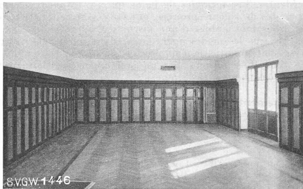
Fig. 9. — Salle de jeux de l'Institut Beau-Soleil, à Villars s/Ollon. Bouche de soufflage dans la paroi du fond. Bouche de reprise dans l'armoire ouverte.
