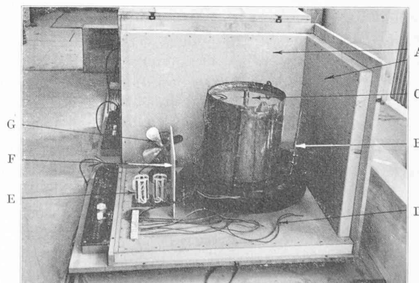
Fig. 2. — Calorimètre adiabatique, ouvert pour la préparation d'une expérience.
