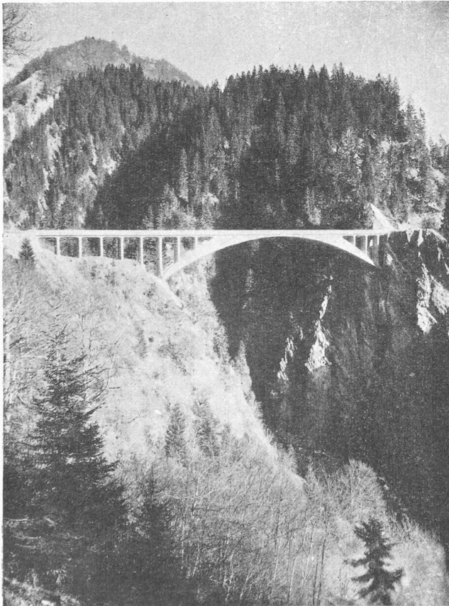
Fig. 3. — Pont de Valschiel. Portée, 43 m. Epaisseur de la voûte, 23-29 cm. Projet Maillart. — Construit, en 1926, par Hartmann & Cie. — Le prototype des ponts à « arc raidi ».
