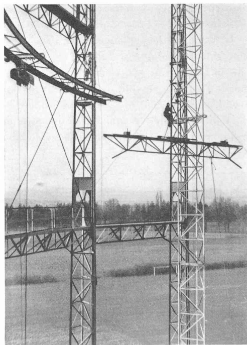
Fig. 10. — Mise en place d'un tronçon de la troisième passerelle.
