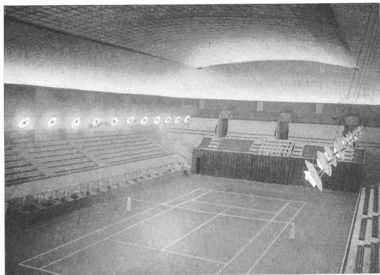
Fig. 2. — Court central, destiné aux compétitions. L'éclairage principal est produit par les appareils. La verrière et la gorge produisent un éclairage décoratif.
