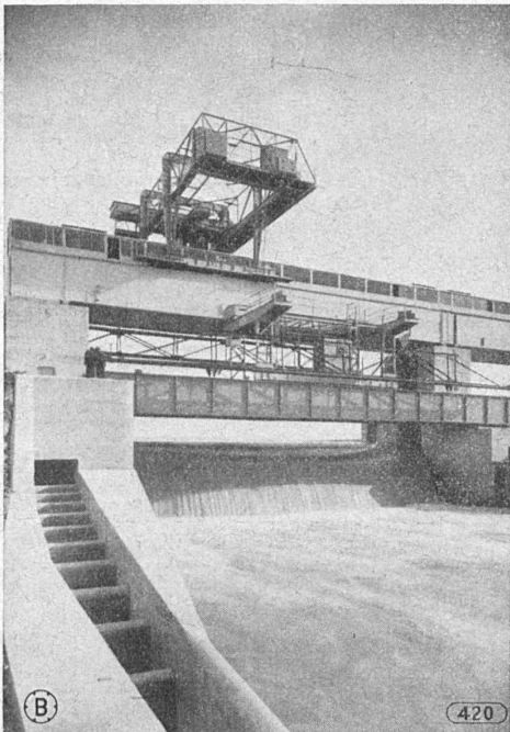
Barrage de Klingnau, vue du côté aval avec grues pour la mise en place des batardeaux.
