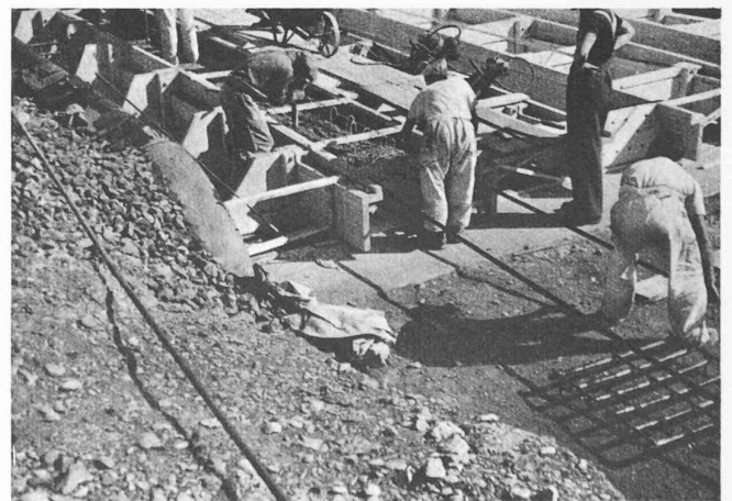
Fig. 2. — Pont de Fribourg. Bétonnage d'une poutre.
