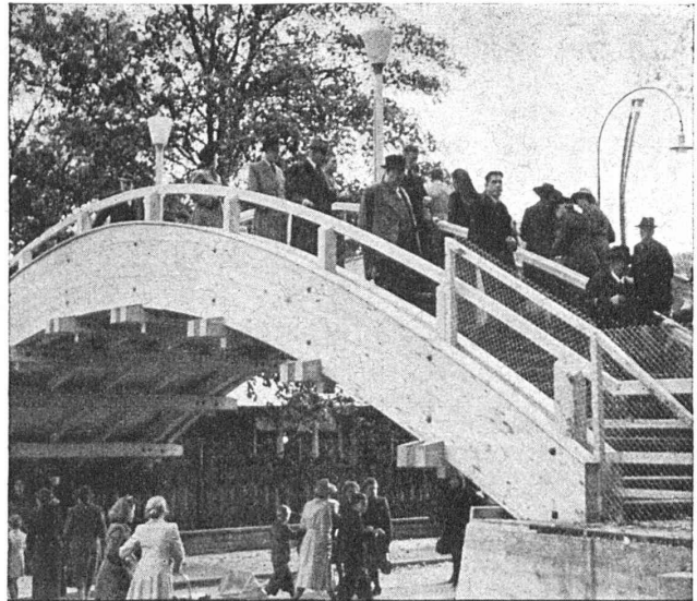
Passerelle sur rue: OLMA St. Gall, 1944. Constructeurs: Osterwald et Bischof, St. Gall.
