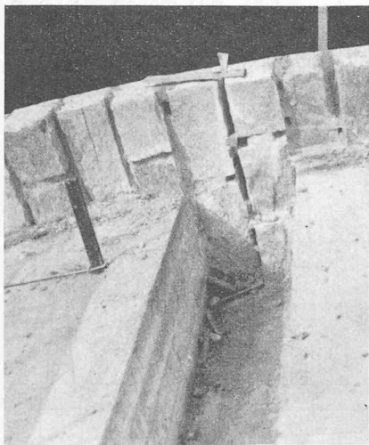
Fig. 14. — Détail d'un joint de retrait d'une voûte.
