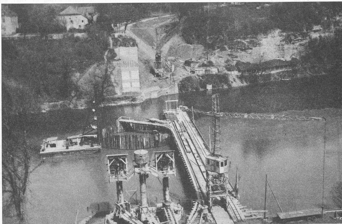
Fig. 8. — Vue générale du chantier.
