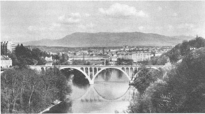
Fig. 2. — Le pont achevé. Avril 1946.
