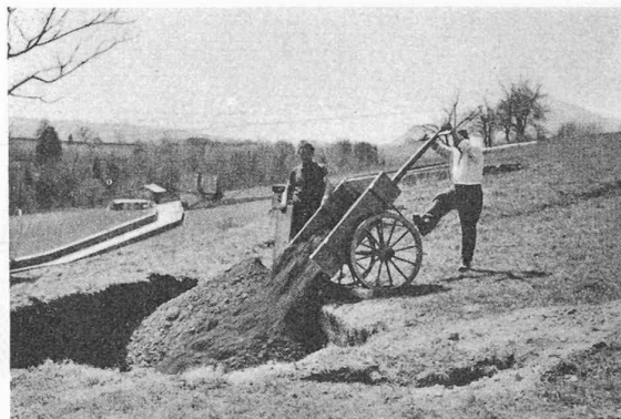
Fig. 9. — Remblayage des trous en surface. Remarquer la fissure limitant les affaissements au S.-W., à 10 m des murs de soutènement et exactement au-dessus de la limite du dépilage.
