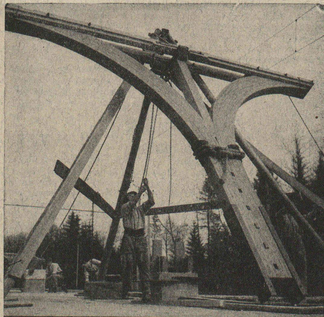
Supports, «système Hetzer», pour le quai de la gare de Ramsei Constructeur: Gribi & Cie S.A., Berthoud
