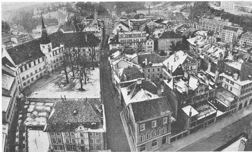
Fig. 1. — Vue d'ensemble de la Cité. Ordre à l'Ouest, désordre à l'Est.
