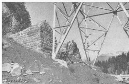
Fig. 8. — Mur de protection, type petit.
