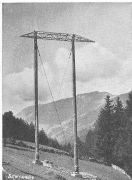
Fig. 4. — Support d'alignement/angle avec socles de fondation.
