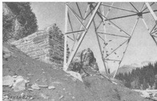
Fig. 8. — Mur de protection, type petit.
