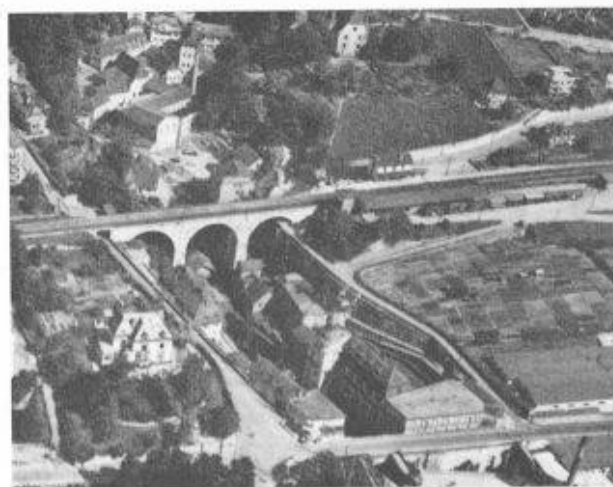
Fig. 4. — Neuchâtel, le pont CFF., direction Lausanne.
