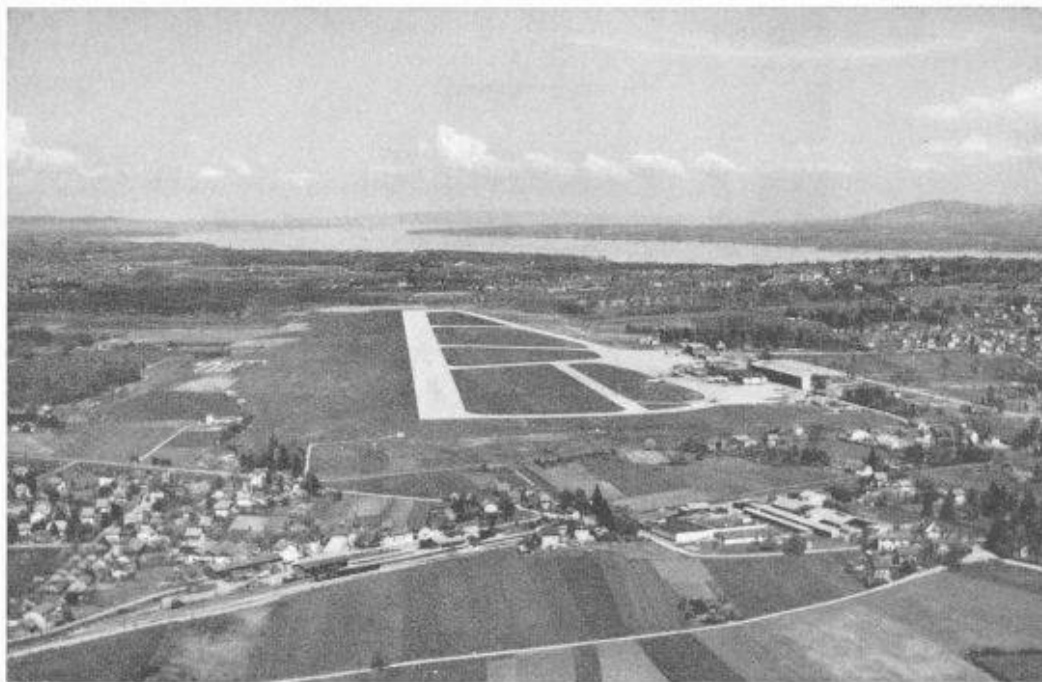
Fig. 22. L'aérodrome de Cointrin, Genève, vu du sud-ouest.
