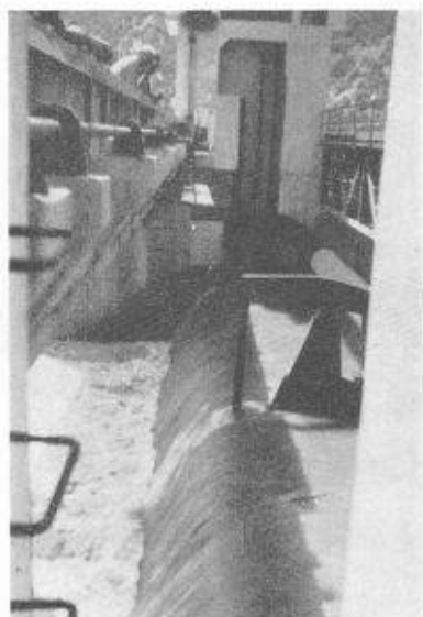
Fig. 5. — Déversement sur la hausse abaissée.
