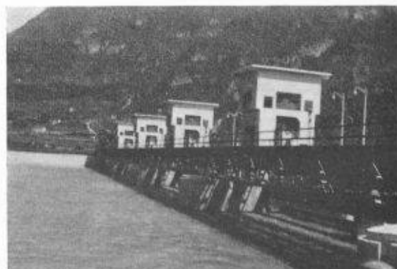
Fig. 3. — Le barrage, vue d'amont.
