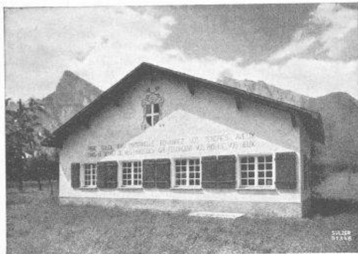
Fig. 2. — Station de pompage de la commune de Chamoson près du pont de chemin de fer de Riddes.
