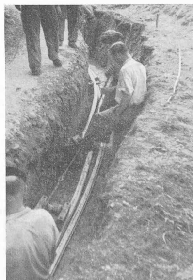
Fig. 3. — Le tirage mécanique dans un coude de la tranchée.
