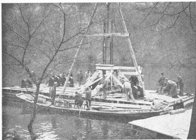
Fig. 12. — La traversée du Rhône : le tirage.
