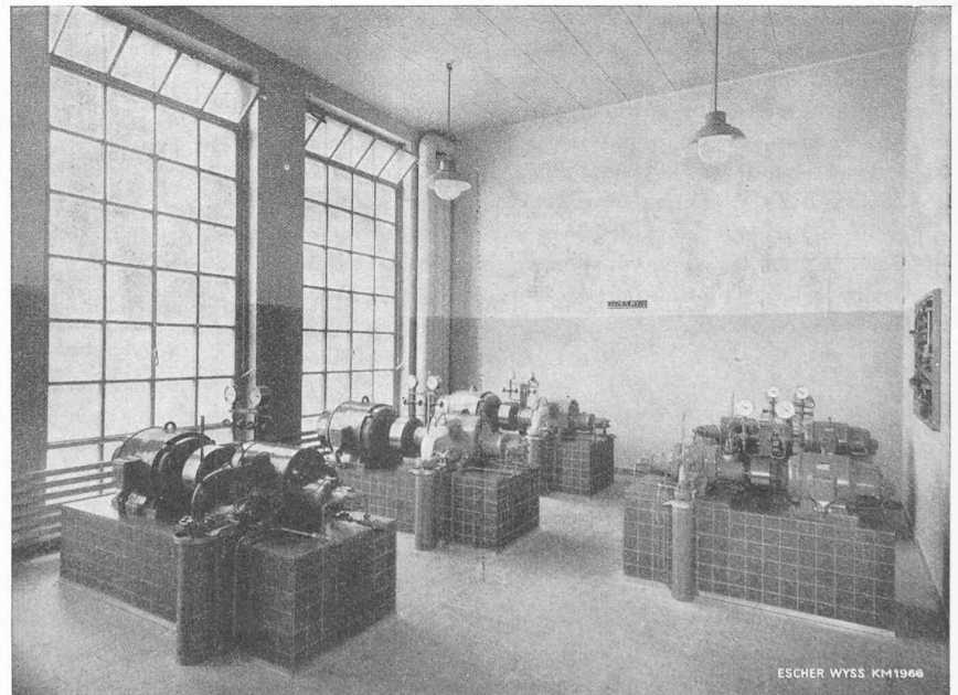
Fig. 34. — Installations frigorifiques. Halle des machines, local des compresseurs.
