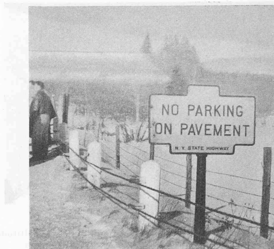
Fig. 10. — LAKE PLACID, New-York . Signal d'interdiction de stationner sur le revêtement. Remarquer aussi le type de barrière composée de gros poteaux en béton et de deux câbles métalliques horizontaux fixés à la hauteur du pare-choc.
