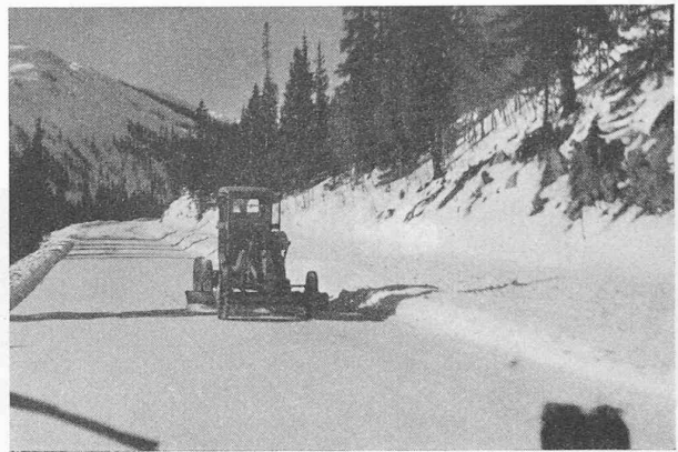
Fig. 16. — LOVELAND PASS, Colorado . Grader à lame en dents de scie. La surface de la neige durcie, ainsi traitée, devient rugueuse et permet de circuler jusqu'à 3600 m d'altitude sans chaînes à neige. On distingue mal sur la figure les stries obtenues.
