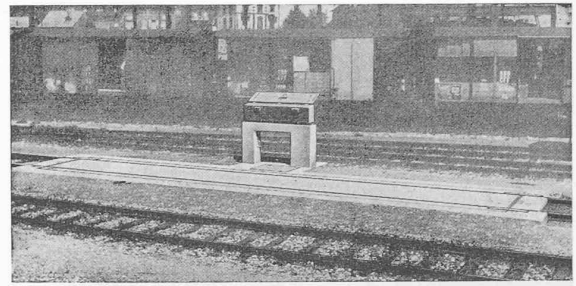
Fig. 19. — Pont à bascule de 70 t, avec interruption de voie, construction à nervures, système Giroud; construction mixte avec deux poutres principales métalliques, enrobées de béton; longueur totale 11,6 m, construit pour une charge maximum de 120 t.
