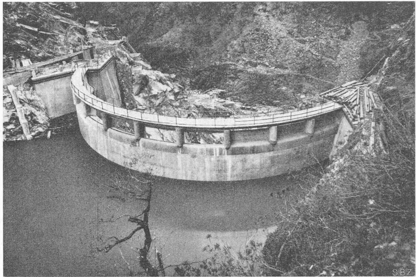
Fig. 23. — Barrage de Panigai du bassin de compensation de l'usine de Pedesina sur le Bitto ; vue d'amont du barrage en voûte mince.
