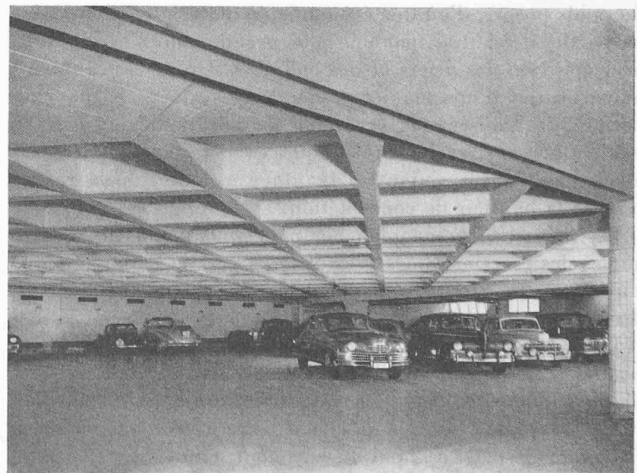
Fig. 1. — Vue de la face inférieure du plancher.
